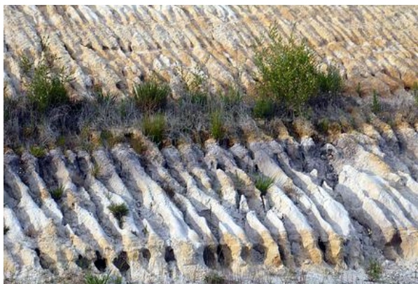
Ravinamentos (ou abarrancamentos) - Sulcos deixados nos terrenos, situados em encostas, pela acção das águas de escorrência.
